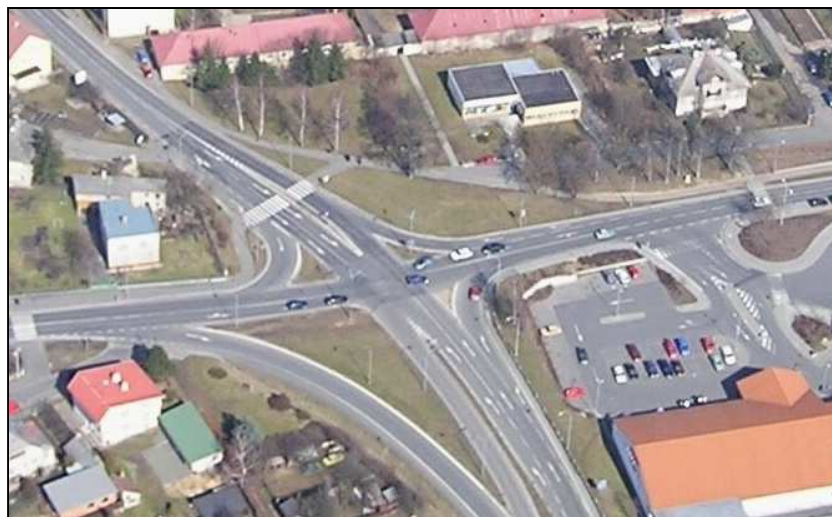
Křižovatka před začátkem stavby.
