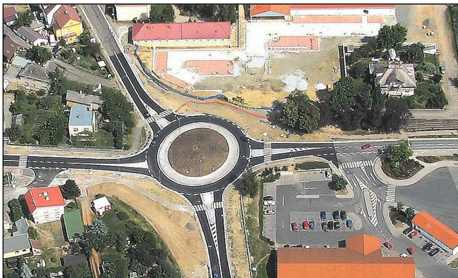
Letecký pohled V. Šoltýse na novou okružní křižovatku ve Stříbře před kolaudací.
